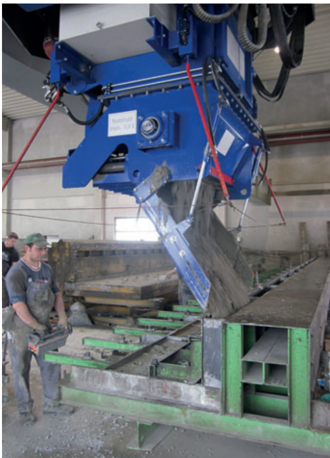
Un seul opérateur est dorénavant en mesure de piloter le nouveau distributeur de béton en toute flexibilité et minutie jusqu'aux coffrages de différents hauteurs.
