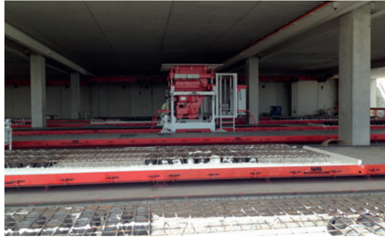
Uma visão do novo galpão de produção da Danstek: a Weckenmann forneceu várias centenas de metros de linha de produção com a mais moderna tecnologia de máquinas.
