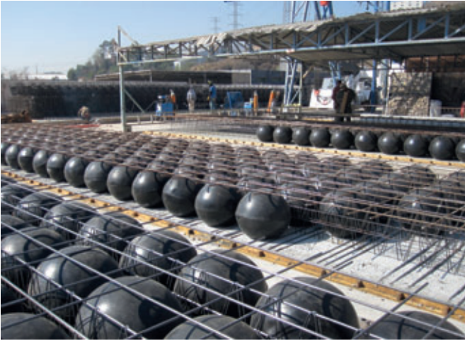
Na nova produção, a empresa mexicana produz predominantemente lajes de esferas ocas de dois eixos, também chamadas de Bubble-Decks, devido ao corpo redondo dos elementos.
