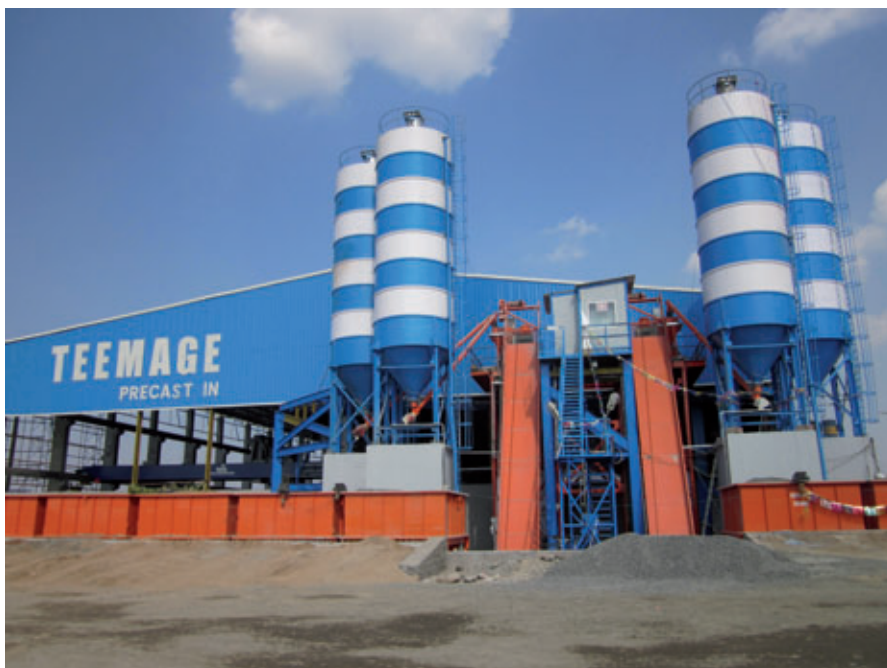
Die Mischanlage von Teemage Precast produziert mit zwei je 1,5-m 3 -Mischern insgesamt bis zu 90 m 3 /h, die sowohl für die Produktion der Fertigteile als auch für Transportbeton verwendet werden
