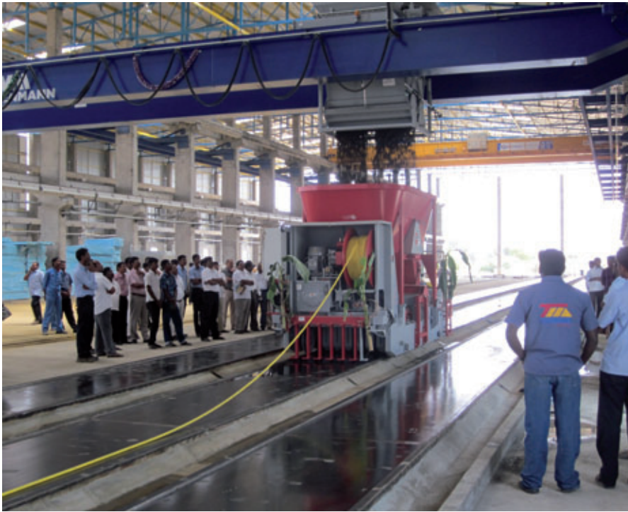
Der Gleitfertiger für die Deckenproduktion wird automatisch kontinuierlich mit Beton versorgt
