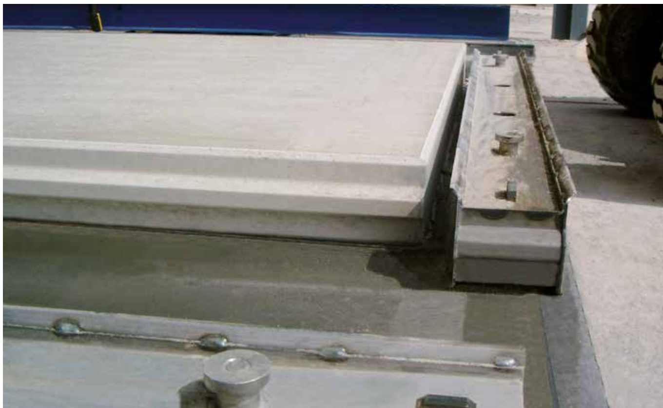
Изготовление массивного стенового элемента с фасками и стыками с использованием опалубки серии М.
