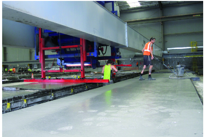
Тандем из выравнивающих реек (слева) и роторный затирщик (справа) для получения высококачественной бетонной поверхности
