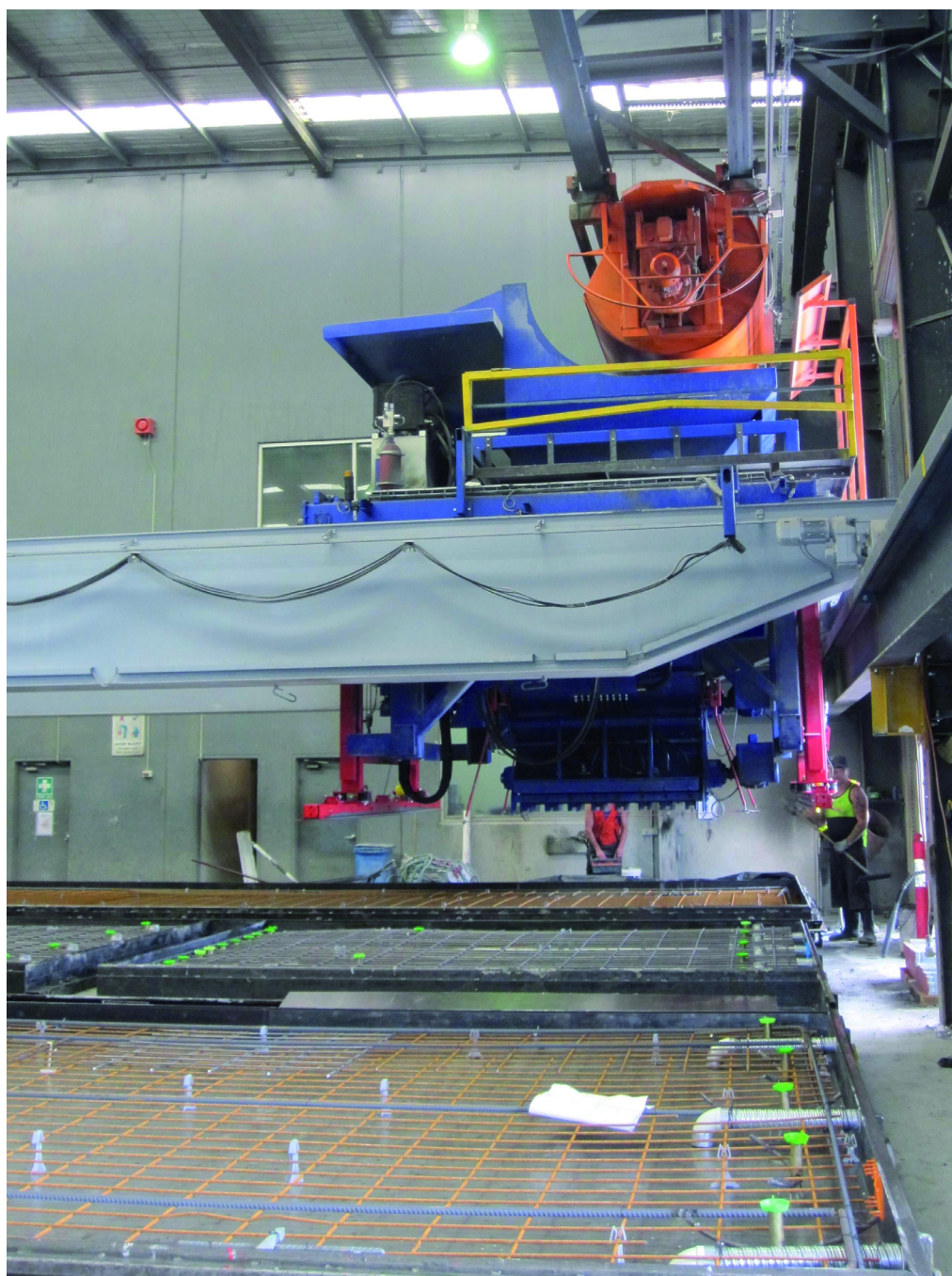
Бетонораздатчик Weckenmann при приемке бетона из кубеля
