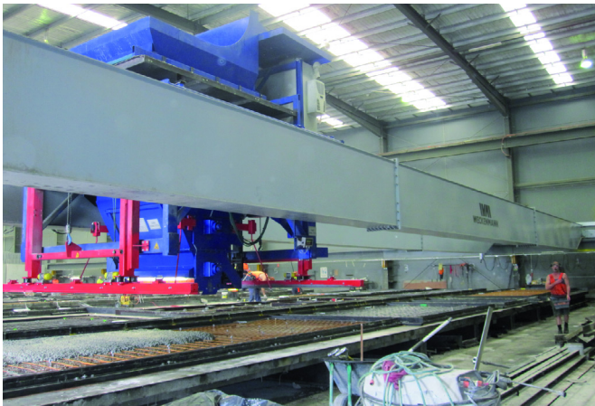
Бетонораздатчик Weckenmann в процессе бетонирования; управление раздатчик с помощью ручного пульта
