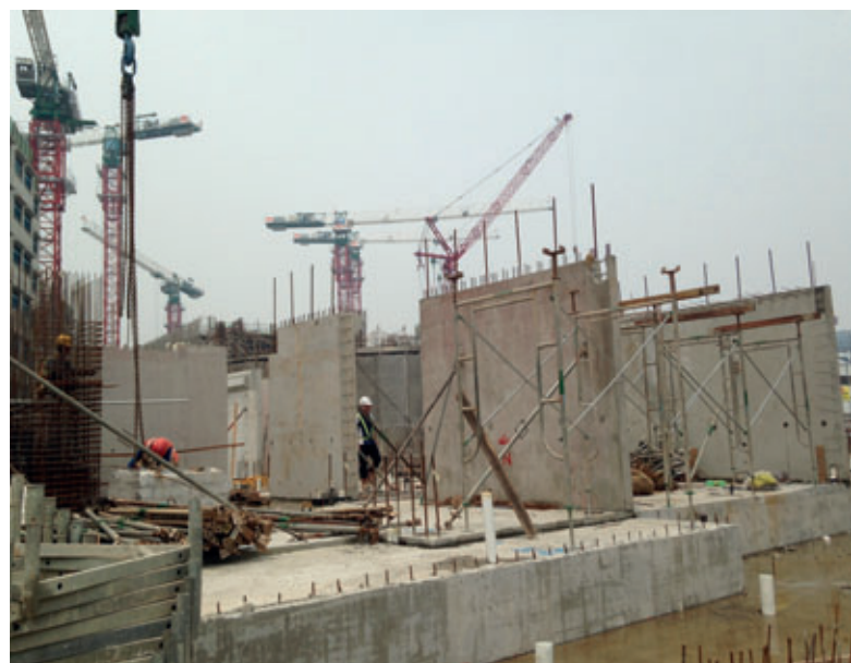
Paredes em concreto pré-moldado montadas
