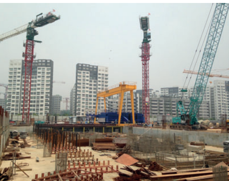
A forma em bateria móvel (MBM) está integrada no canteiro de obras
