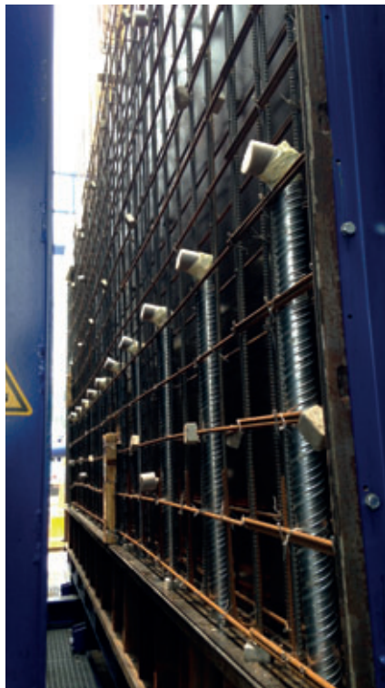
Visão de uma câmara preparada para concretagem
