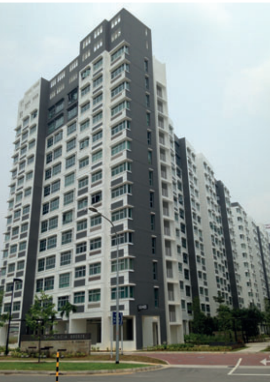
Complexo residencial construído com elementos pré-moldados
